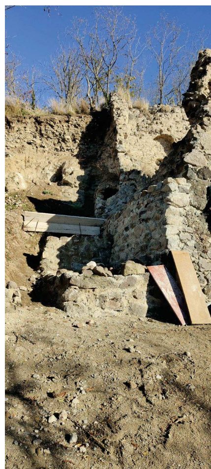
Consolidation des bases de la maison Parpaleix
