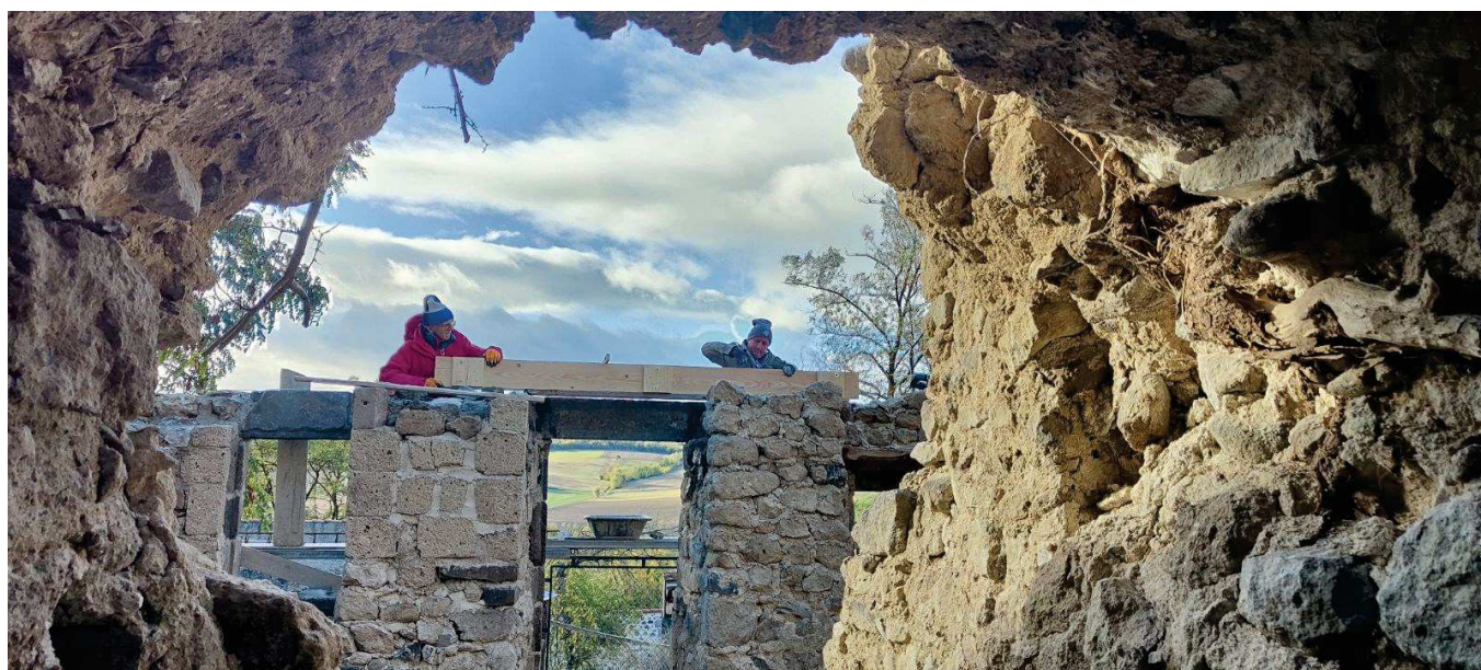
Coffrage du linteau de la porte principale de la maison Parpaleix lors d'une opération coup de poing
