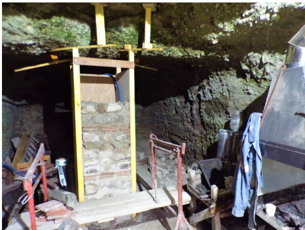
Un pilier pour soutenir la voute de la cave a dû être mis en place par Gérard.
