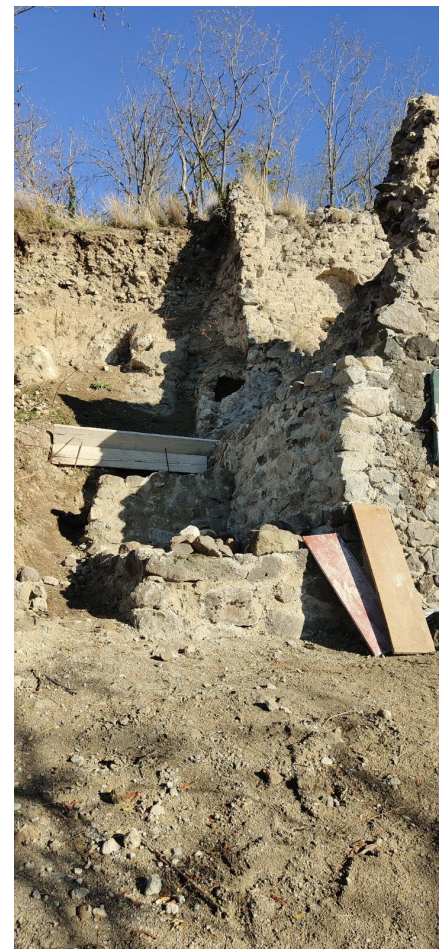
Consolidation des bases de la maison Parpaleix
